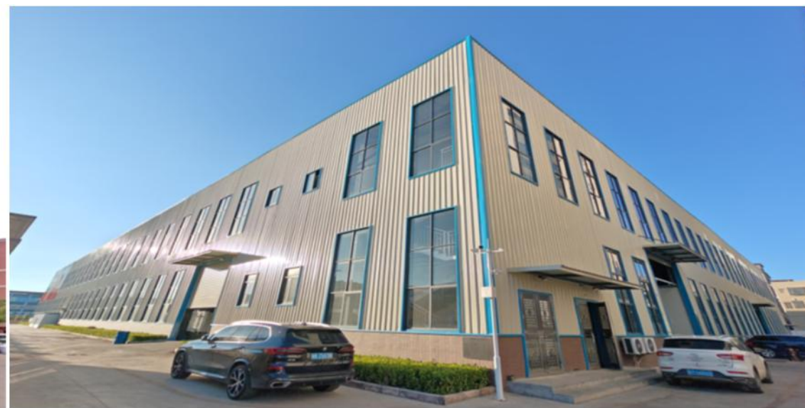
良井工場 2023年竣工
